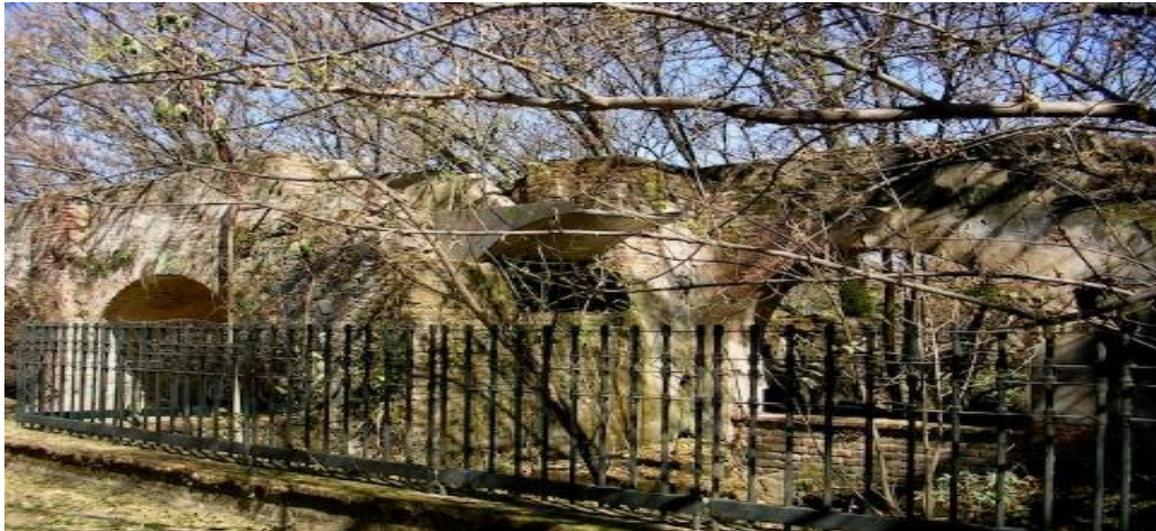
Fotografía 1. Lo que se conserva de la fábrica de La Escoba al 2017.
